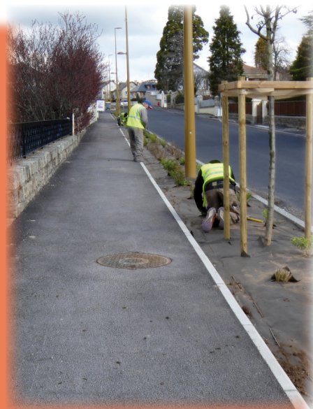
Travaux voirie Route de Paris
